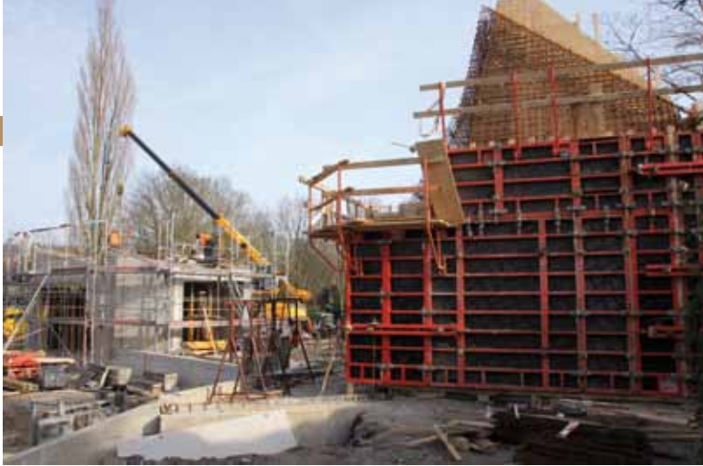
■ Baufortschritt: Tunnel durch den Regenwald
