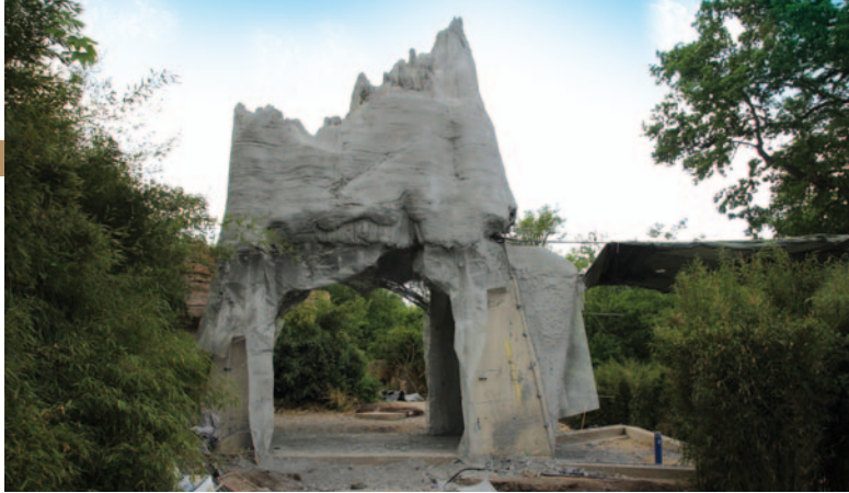
■ Eingangsportal: Durch einen Riesenbaum in den Regenwald
