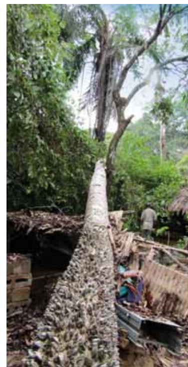
■ Sturmschaden: Die Tierklinik wurde von einem Baum zerstört
