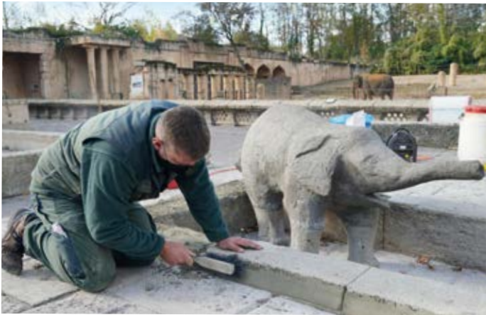
Betongestaltung: Jens Bornemann-Klingeberg erneuert den Springbrunnen
