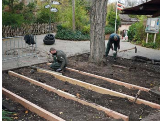
Alles im Lot: Erneuerung der Holzböden
