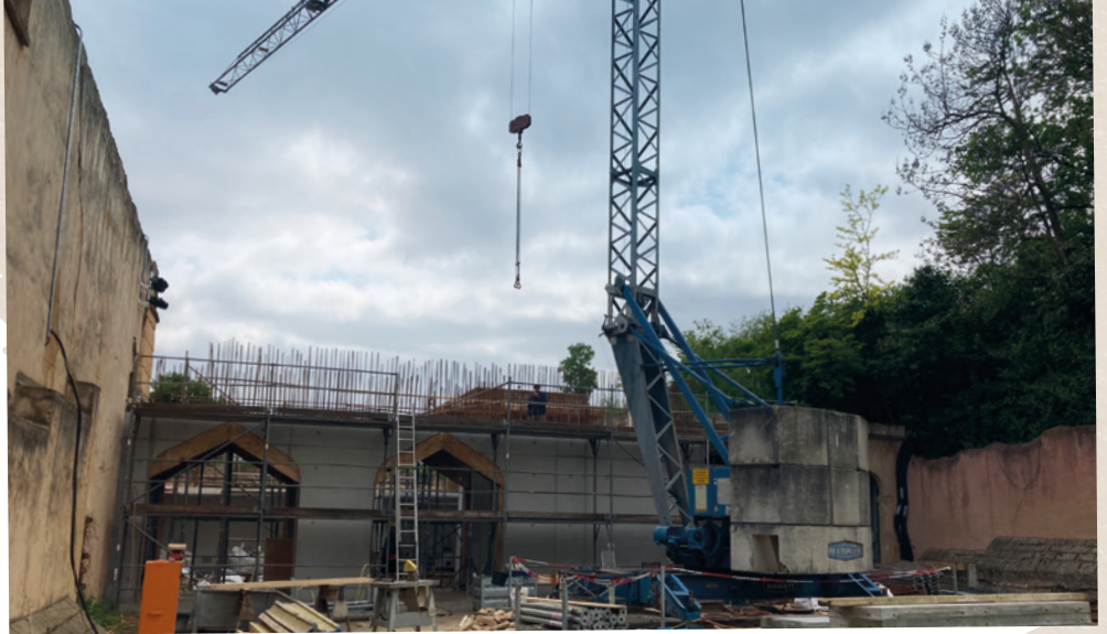
Kraneinsatz: Übergang zum bestehenden Elefantenhaus
