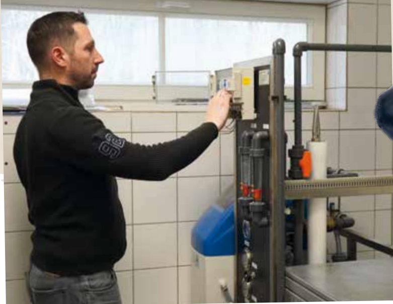
Alles im Blick: Bauleiter Marco Hustedt kontrolliert den Wassermischer
